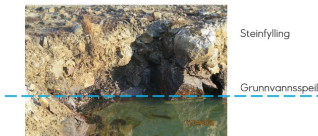
Figur 14. Profil gjennom grøftet sprengsteingsfylling sør for sikringsbassenget
