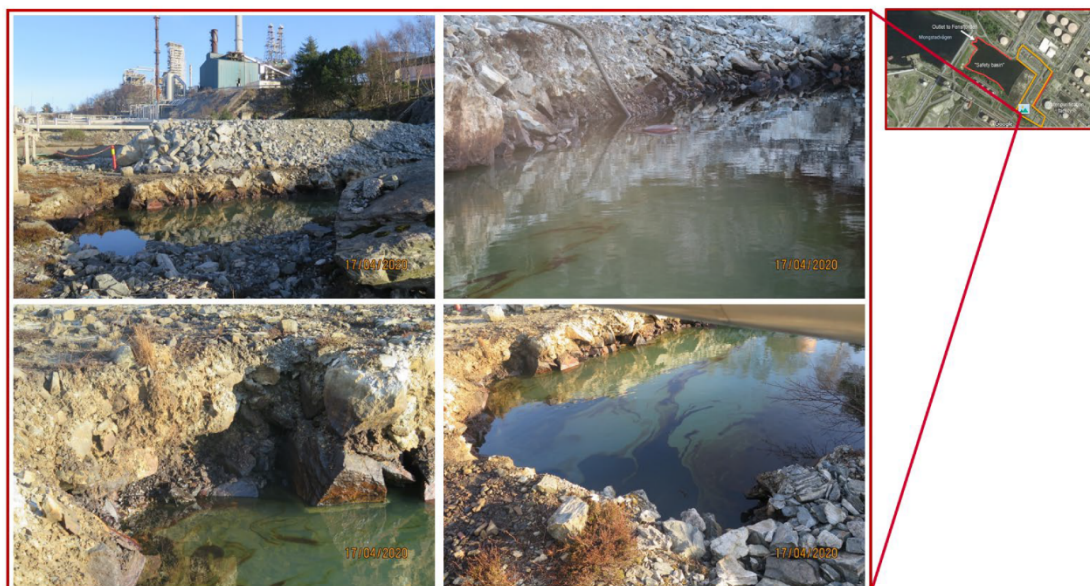
Figur 1. Bilder tatt fra grøfting sør for sikringsbassenget 17.04.2020 viser olje i fri fase
