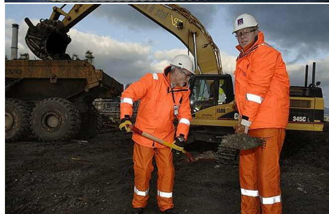
Byggestart på Energiverk Mongstad
