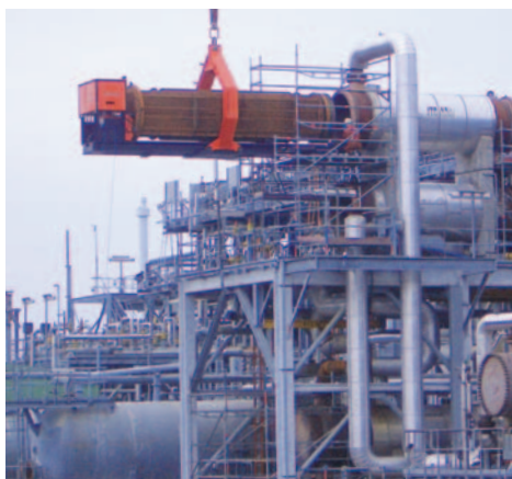
Trækning af varmeveksler i forbindelse med turnaround.
