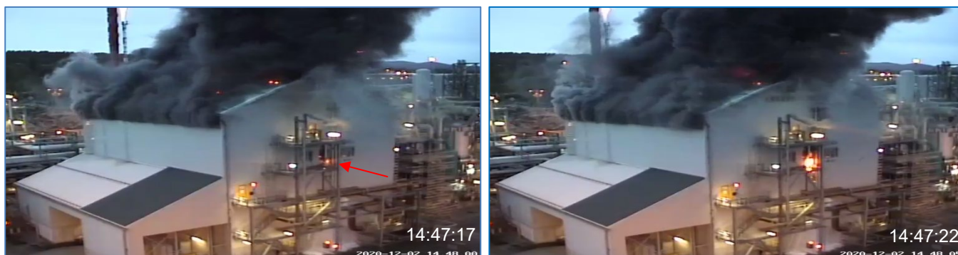
Figur 6-8 Bilder med flammer fra taket og gjennombrenning av nordvegg (Camera6)
