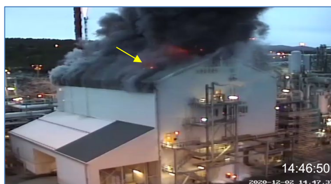
Figur 6-7 Bilder med flammer fra taket. Til høyre, gjennombrenning av takplater (Camera6)
