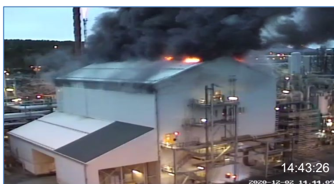
Figur 6-7 Bilder med flammer fra taket. Til høyre, gjennombrenning av takplater (Camera6)
