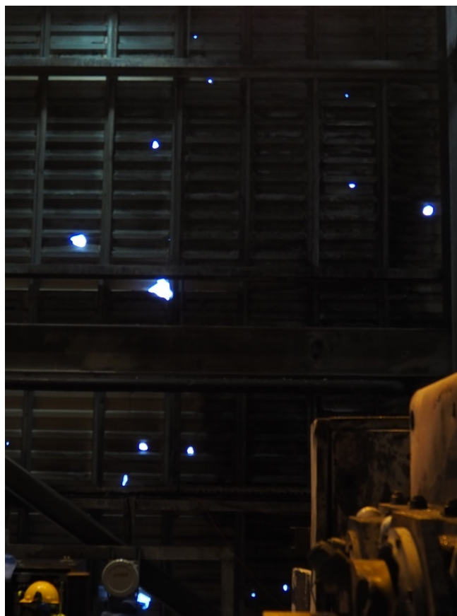
Figur 6-14 Bildet til venstre viser utslynget fragment med vekt 10,7 kg og ventil tilhørende syntesekompressor (casing drain på kompressor) som ble truffet. Bildet til høyre viser minst 14 hull i nordvegg, sannsynligvis fra utslyngede fragmenter
