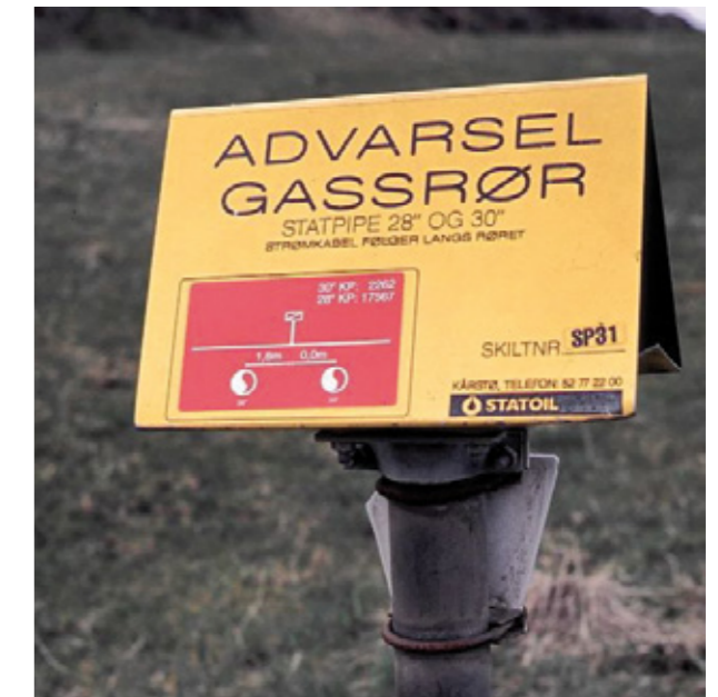
Merking av gassrør langs rørledningstraséen.
