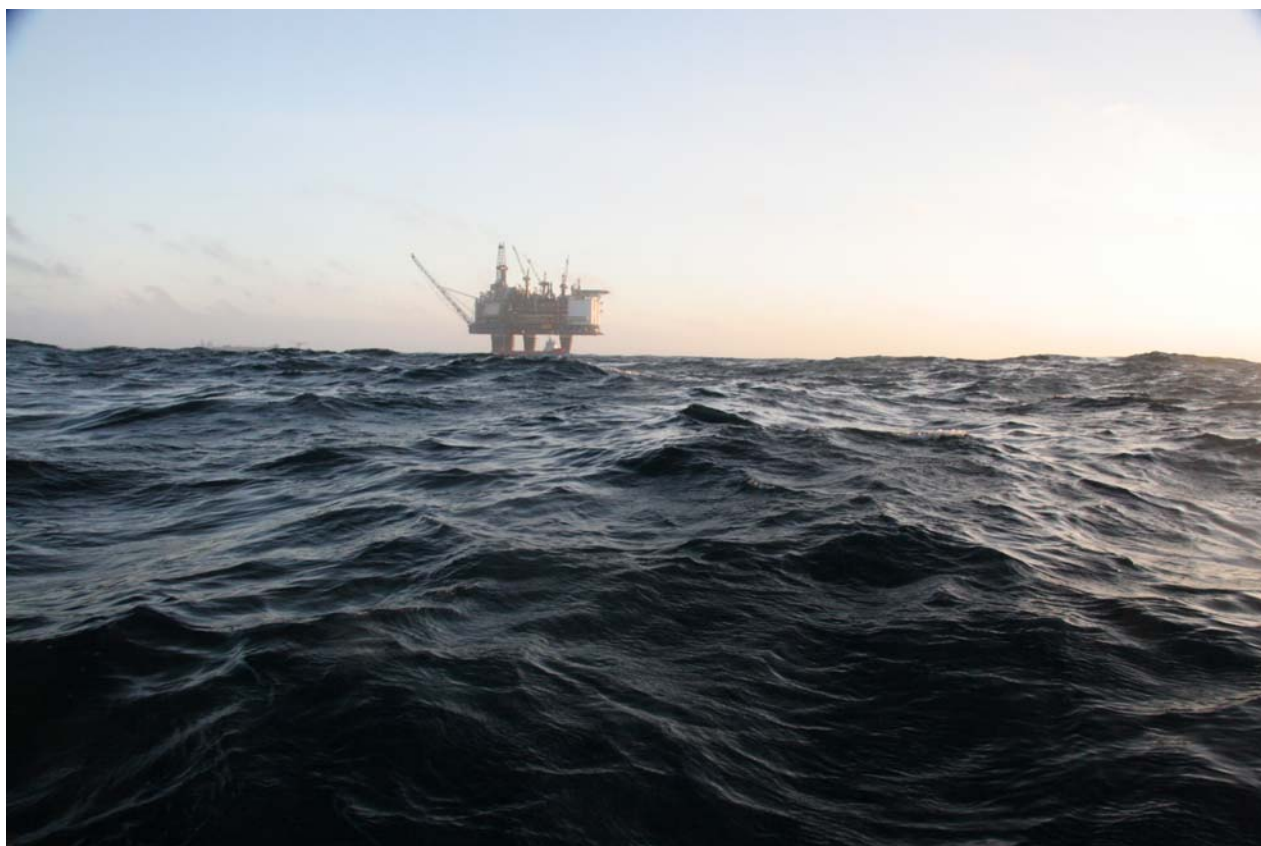
Figur 6 Gullfaks A plattformen.
