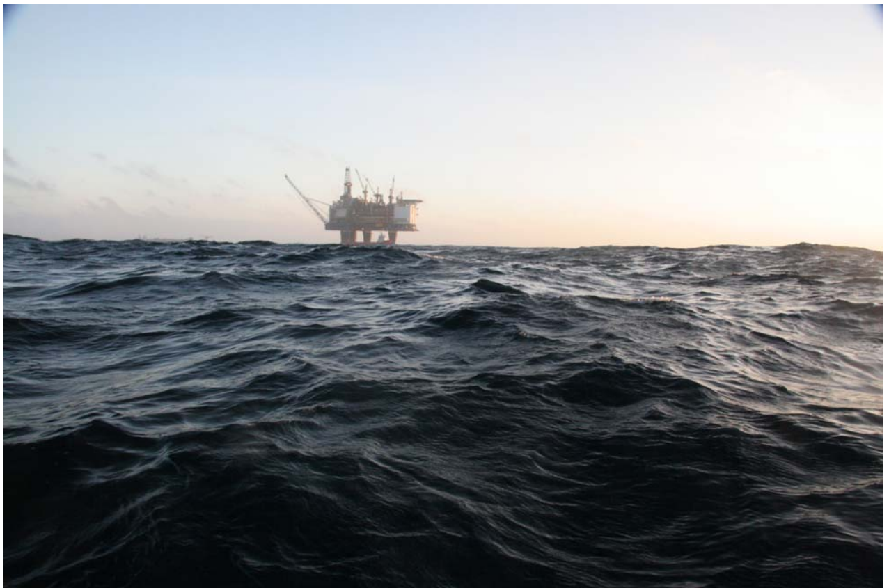
Figur 6 Gullfaks A plattformen.
