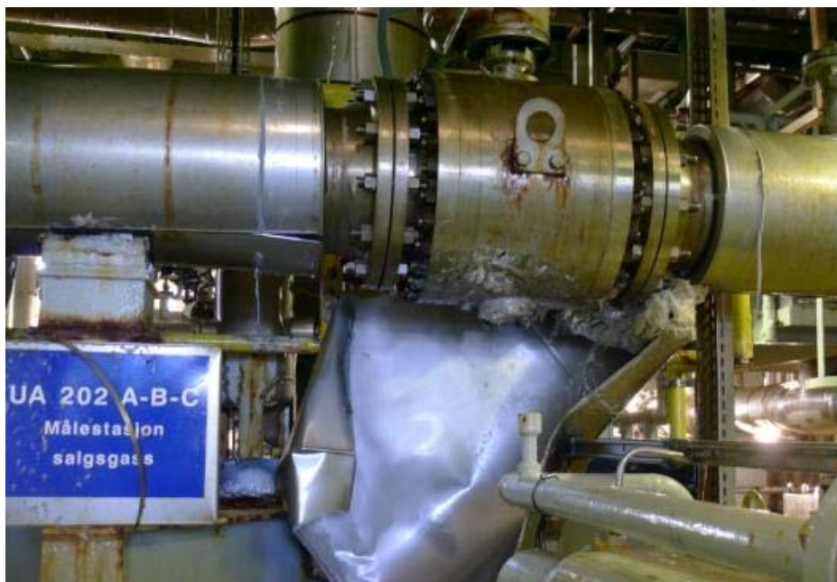
Bilde 1.1.2 Flens mellom rørstykke og Stengeventil #3 etter lekkasjen
