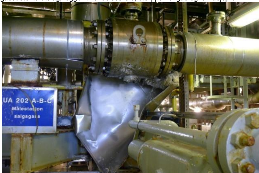
Figur 1. Bilde av ventil hvor flenslekkasjen skjedde.
